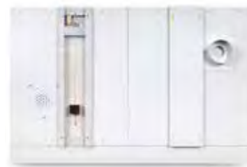
Détail contreponds arrière pour fermeture automatique de la porte en cas d'incendie
