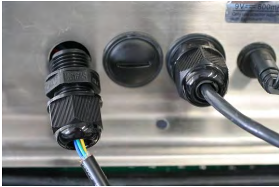
Kabel aan de terminal vastdraaien
