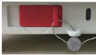
Bloqueado con cable de sellado
